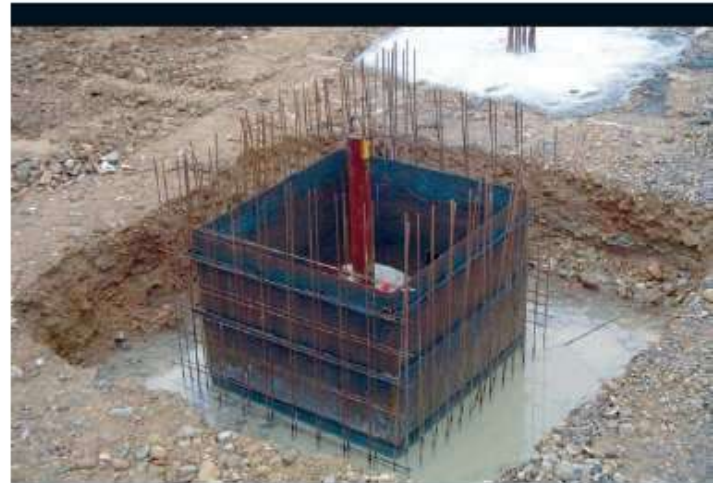
Foso de ascensor
