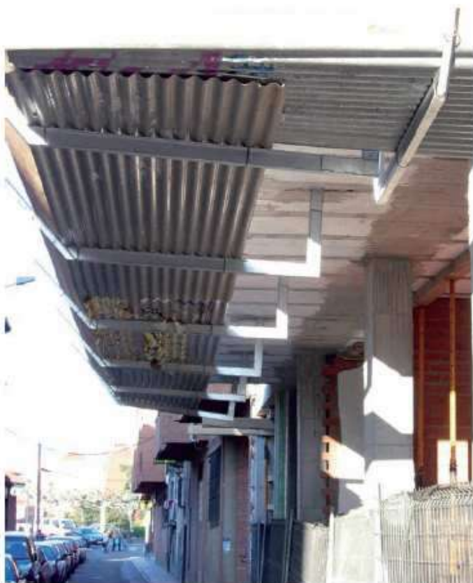
Instalación de marquesina
