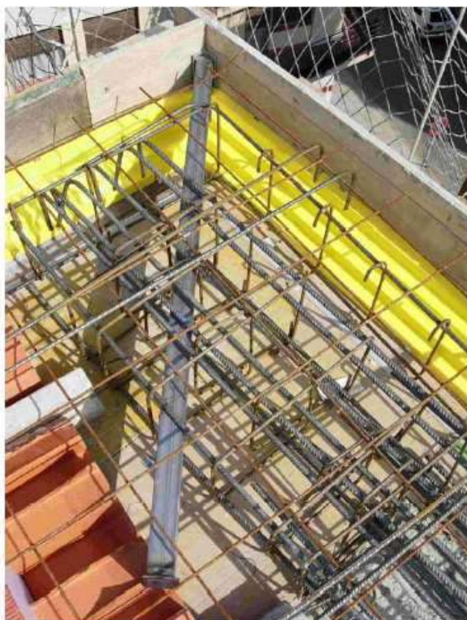
Detalle instalación esquina
