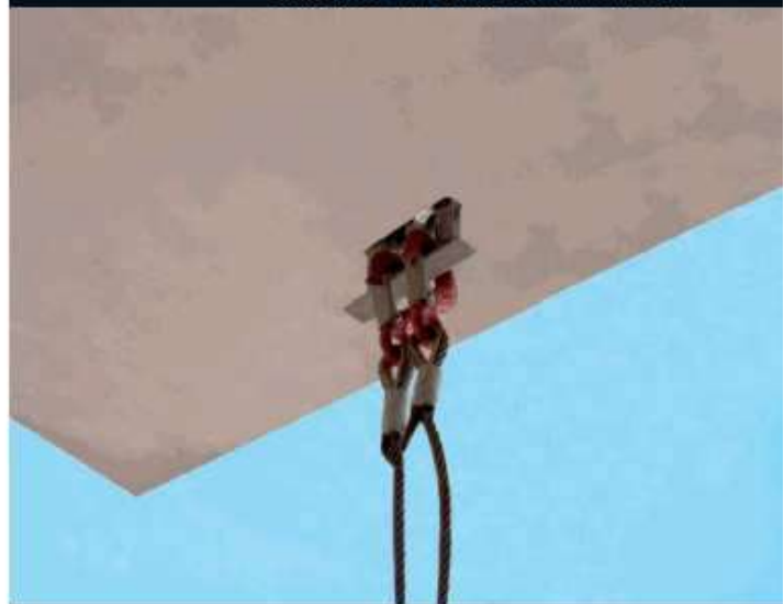
Anclaje bajo alero colocado
